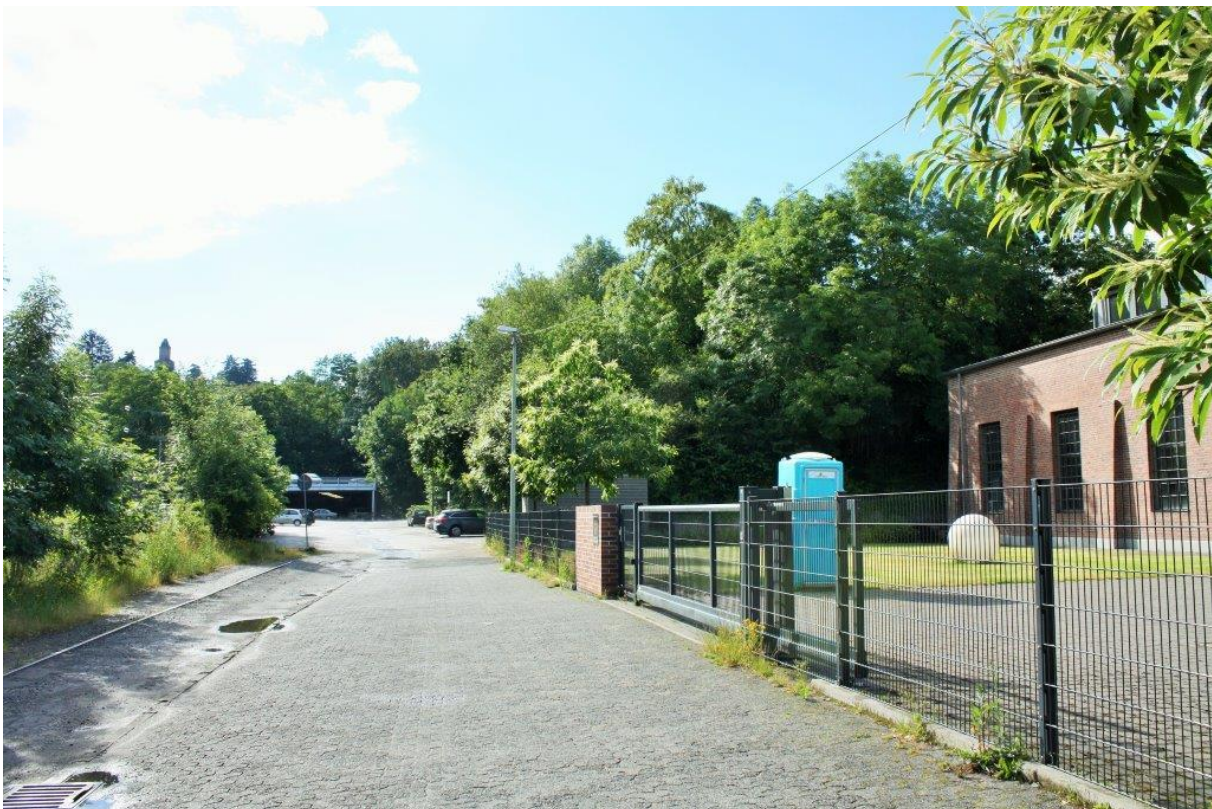
Blick vom Lokschuppen/Gleis 3 auf Baufeld II und Baufeld VI
